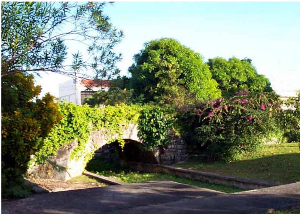
Puente de San Antonio.
