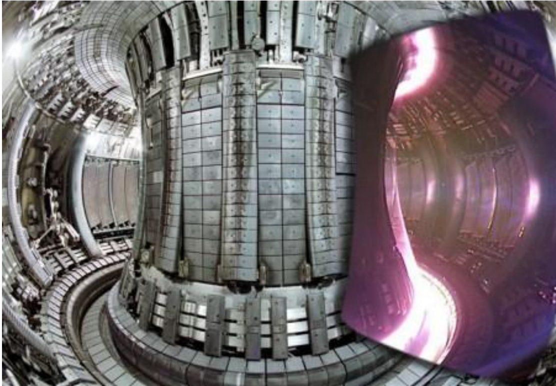
Interior del Tokamak JET detenido y (en la inserción) funcionando, con plasma en su interior.
